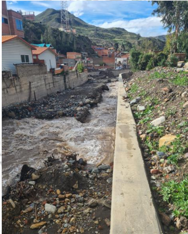
CONST. OBRAS PARA LA REDUCCIÓN DE RIESGOS Y ADAPTACIÓN AL CAMBIO CLIMÁTICO EN EL RÍO PALCA - TRAMO POBLACIÓN DE PALCA - MUNICIPIO (PALCA)
