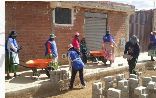
CONST. ENLOSETADO AV. BARTOLINA SISA URBANIZACION EL SANTUARIO DISTRITO MUNICIPAL N°7 (CIUDAD EL ALTO)
