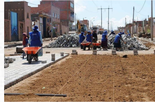
CONST. ENLOSETADO AVENIDA COSTANERA (CIUDAD EL ALTO)
