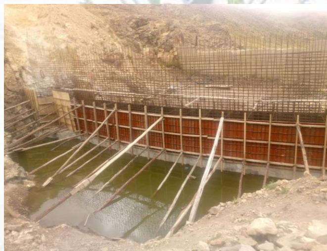
“CONST. SIST. RIEGO PRESA SENKATA ALTA (CALAMARCA)”
