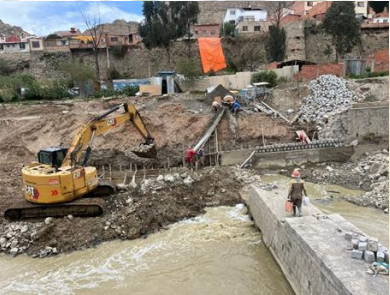
REHAB. CANALIZACIÓN RIO IRPAVI AGUAS ARRIBA C.4 IRPAVI Y EMBOVEDADO FLOR DE IRPAV (LA PAZ)
