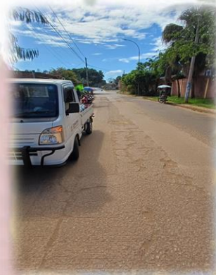
REHAB. DE LA AV. JUAN OLIVEIRA BARROS EN EL DISTRITO 3 DEL MUNICIPIO DE (COBIJA)
