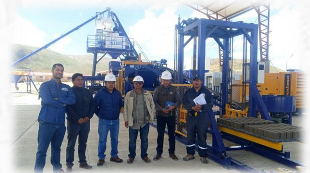
IMPLEM. PLANTA DE PREFABRICADOS DE HORMIGON PARA EL MUNICIPIO DE ORURO (ORURO)
