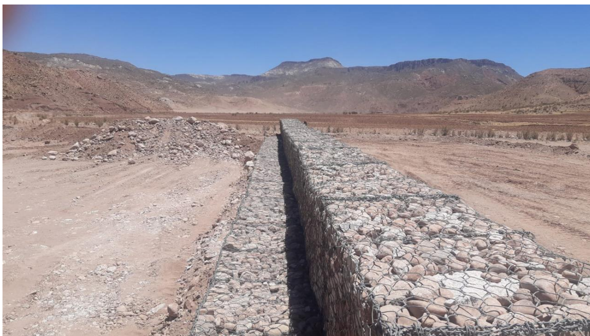
Figure 11 CONSTRUCCION DE DEFENSIVOS EN TIQUIPAYA - PROGRAMA BOLIVIA RESILIENTE
