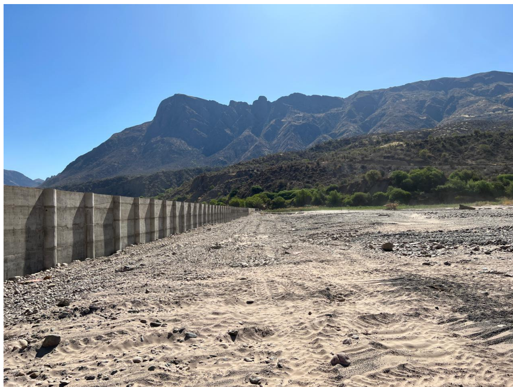
Figure 10 CONSTRUCCION DE DEFENSIVOS EN CHUQUISACA - PROGRAMA BOLIVIA RESILIENTE
