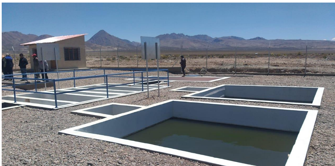
Figure 13 CONSTRUCCIÓN DEL SISTEMA DE ALCANTARILLADO SANITARIO EN TOMAVE #POTOSÍ
