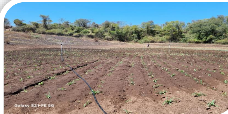
CONST. SISTEMA DE RIEGO PRESA LOMA ALTA (GRAN CHACO - CARAPARÍ)
