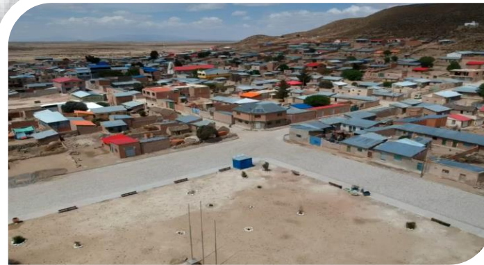
CONST. ENLOSETADO DE CALLES UCUMASI (GAIOC SALINAS) DPTO. ORURO
