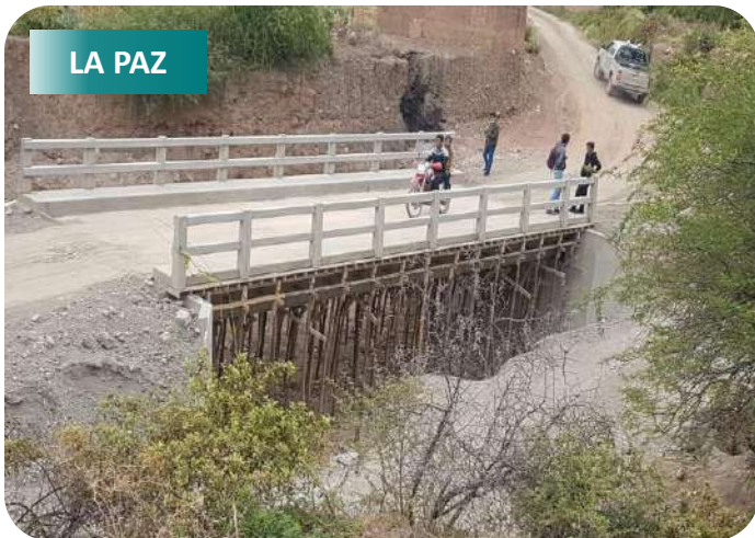
CONST. PUENTE VEHICULAR WILA JAWIRA (LURIBAY)
