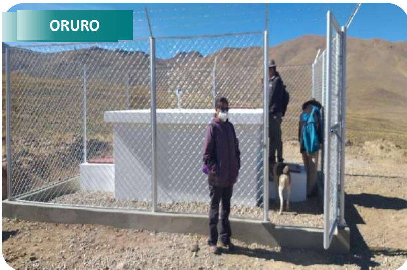
CONST. SIST. AGUA POTABLE DEJAHUTA (ANTEQUERA) ORURO
