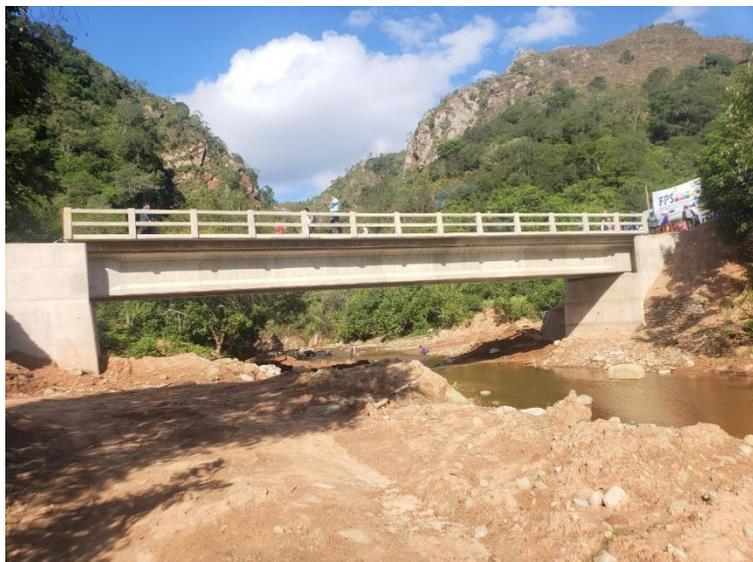
una longitud total de 26 metros y un ancho de calzada de 4 metros. Longitud promedio de 290 m2.
