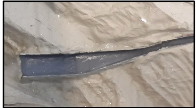
Foto 5 Salida del vertedero Presa Chacaltaya
