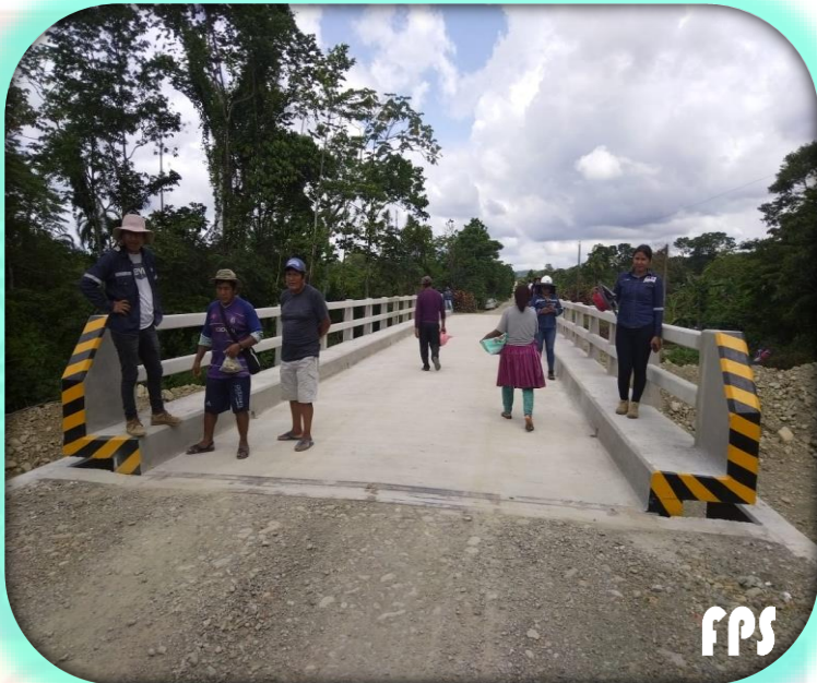
CONST. PUENTE VEHICULAR VILLA FLORES (PUERTO VILLAROEL) COCHABAMBA
