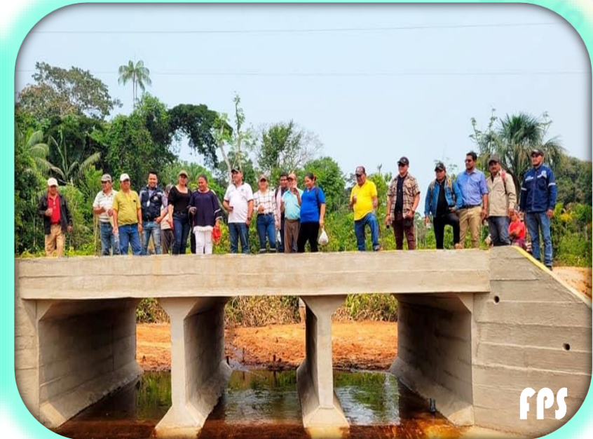
"Construcción Obras de Arte Camino Vecinal Comunidad Las Piedras, Lago Victoria "PANDO
